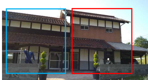
赤枠部分はお施主様ご自身で解体されます。青枠部分の改修は、屋根の葺き替えと、室内を梁を見せる大空間にします。
