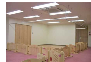
花キュー園改修工事
