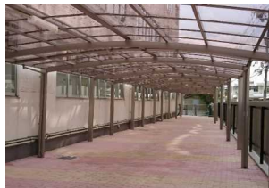
ブロック塀撤去・フェンス設置 自転車置場取替え工事
