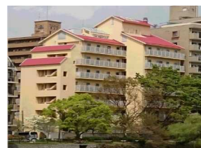
外壁明装工事
