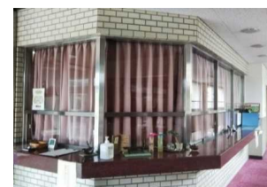
事務室窓口カーテン取付工事
