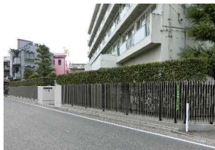
C B 塀改修工事
