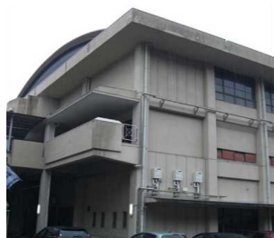
軒下改修工事
