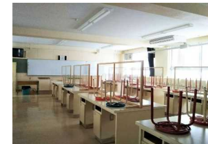
飛散防止スクリーン設置工事
