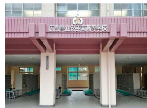
庇校名取付工事
