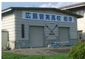
艇庫看板取付工事
