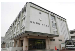
校訓取付工事
