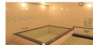
浴室改修工事
