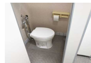
男女トイレ改修工事
