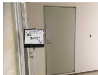
鋼製建具工事
