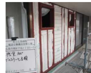
金属工事(枠取付)
