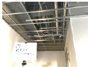
内装工事(軽天組完了)
