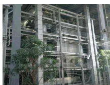
広島市環境局中工場
