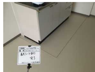
内装工事(長尺シート貼り)
