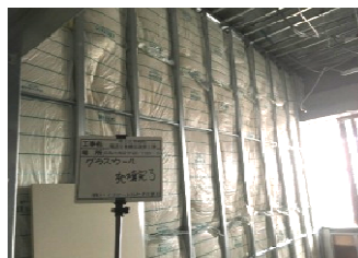
内装工事(グラスウール充填)
