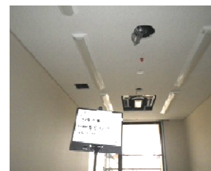
電気工事(照明器取付)
