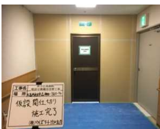
仮設間仕切り設置
