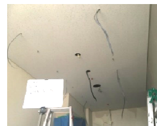
内装工事(吸音板貼り完了)
