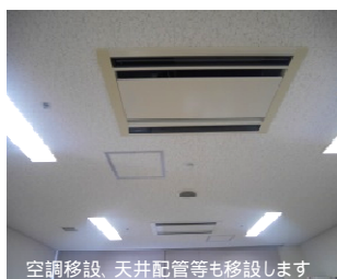
空調移設、天井配管等も移設します
