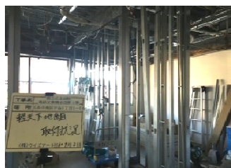
内装工事(軽鉄下地組状況)
