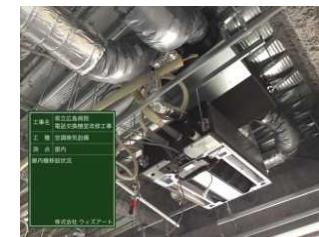
空調設備(室内機移設)
