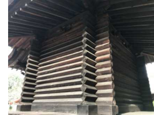
【校倉（あざくら）造り】 柱を用いず、木材を井桁（いげた）に組み上げて壁とした構造の建物。日本では弥生時代ごろから倉庫などに用いられた。奈良時代に建てられた東大寺正倉院は、現存する代表的な建物。
