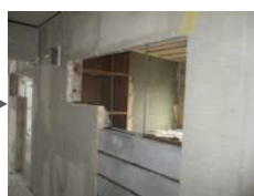
入口解体後CB積み
