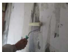
室内壁シーラー塗布
