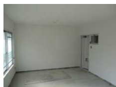
室内壁クロス完了
