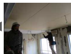
天井ボード貼り
