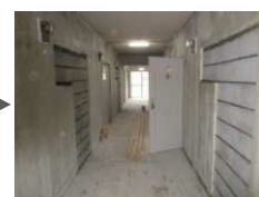
廊下CB積み完了
