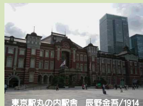
東京駅丸の内駅舎 辰野金吾/1914
