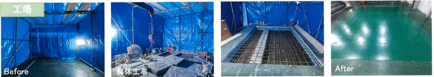
【(株)機械基礎新設工事】～中区～（伊藤 敬矩）
