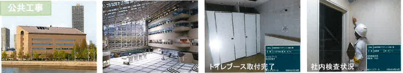
【広島県情報プラザトイレ改修工事】～中区～（丸口 俊秀 伊藤 敬矩）
