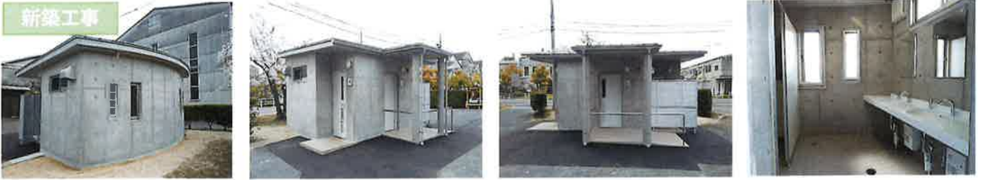
【(株)N 屋外トイレ建替工事】～安芸区～（設計:伊藤 弘幸 施工担当:竹本 三雄）
