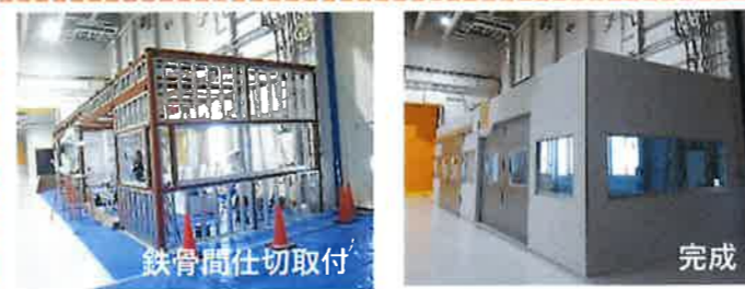
【工場内作業室新設工事】大型スライドドア採用。
