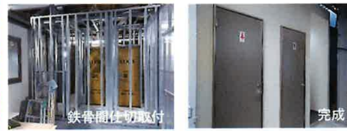
【工場内トイレ新設工事】配管調査から始まり工期は3週間。
