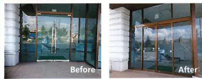
【玄関扉取替工事】開き扉から自動扉へ取替。
