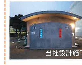
【屋外トイレ新築工事】
