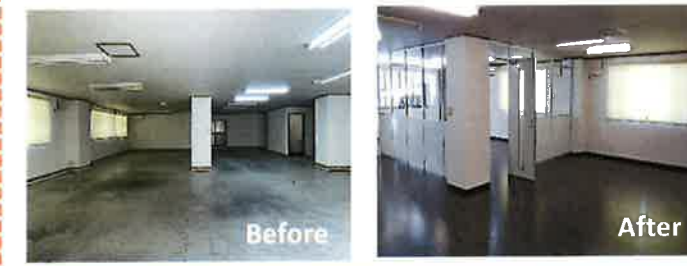
【事務所改修工事】間仕切りをして事務所と倉庫に改修。
