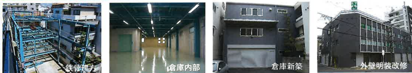
【倉庫新築及び本体外装改修工事】～中区～ 倉庫新築に伴い、本社内外部の改修もさせていただきました。
