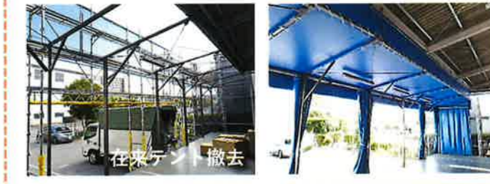
【テント張替え工事】レール・鉄骨も錆止め塗装仕上げしました。
