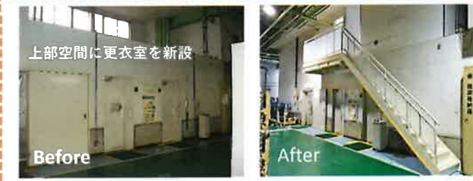
【更衣室新設工事】階段も上り下りしやすくように設計施工。
