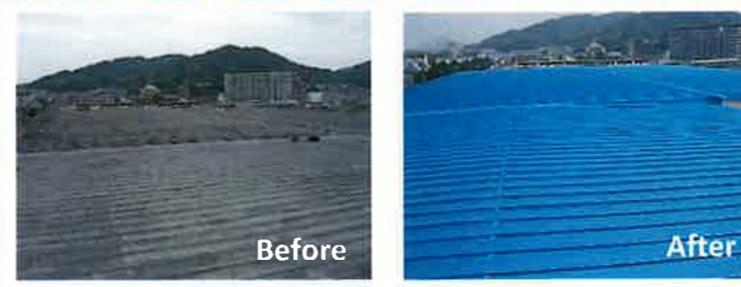
【工場屋根防水工事】ルーフィング防水新設。
