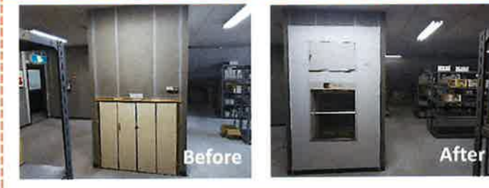
【リフト改修工事】リフト改修に伴い開口部廻りを改修。
