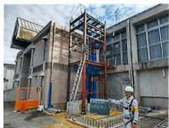
【東野公民館福祉環境設備その他工事】～安佐南区～（竹本・伊藤敬） 東野公民館にエレベーター設置の為、エレベーター棟の増築と非常階段を新設しました。5ヶ月の工事でした。
