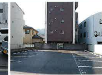
【駐車場オーバーレイ舗装工事】～東区～（伊藤） 駐車場の舗装及び区画線引きしました。
