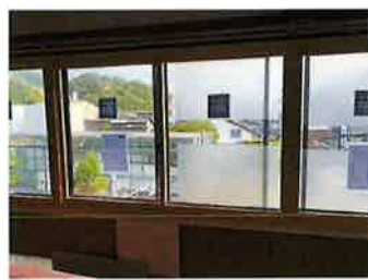
【S様邸サッシ取替工事】～安佐北区～（伊藤）内窓を取付しました。
