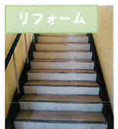
【(株)T 階段長尺シート貼替工事】～坂町～（伊藤） 階段タイル・クロス・床貼替えをしました。
