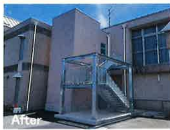
【東野公民館福祉環境設備その他工事】～安佐南区～（竹本・伊藤敬） 東野公民館にエレベーター設置の為、エレベーター棟の増築と非常階段を新設しました。5ヶ月の工事でした。
