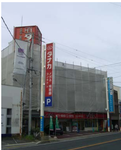
安芸郡海田町 外壁明装
